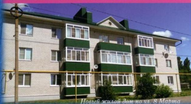
Новый жилой дом по ул. 8 Марта
